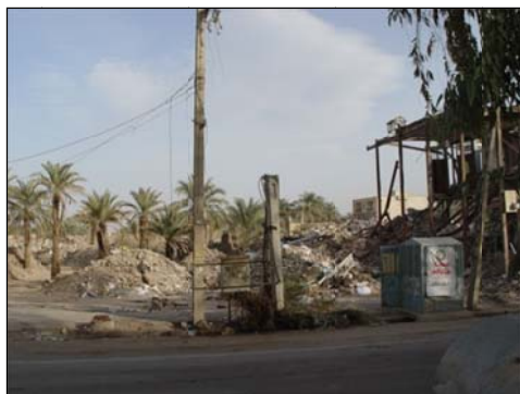
شکل ۳: شکست پایه پست هوایی در زلزله بم [۱]
