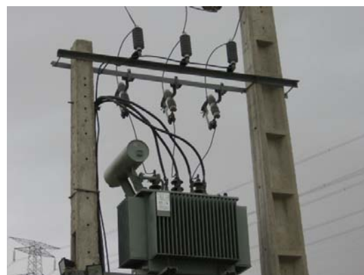
شکل ۷: کیسینگ های نصب شده در منطقه وردآورد
